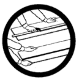
Coupage à la main de panneaux muraux contenant de l'amiante
